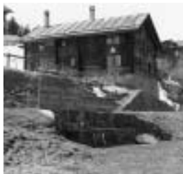
Brunnen in Miraniga mit bereit gestelltem Deckbrett gegen Eis, 21. April 1985.
