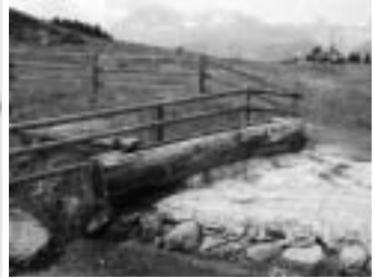
Trogg mit Kännel und Überlauf bei Feuerstelle Sassli.
