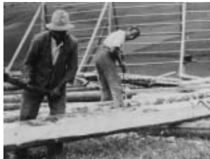
Misanenga 1941. Ludwig Tschuor-Alig (1905-72) mit Zimmermannsaxt, Heeäggsch am zuschneiden, bhaua eines Balkens. Eugen Sax-Noack (1911) am Löcher bohren.
