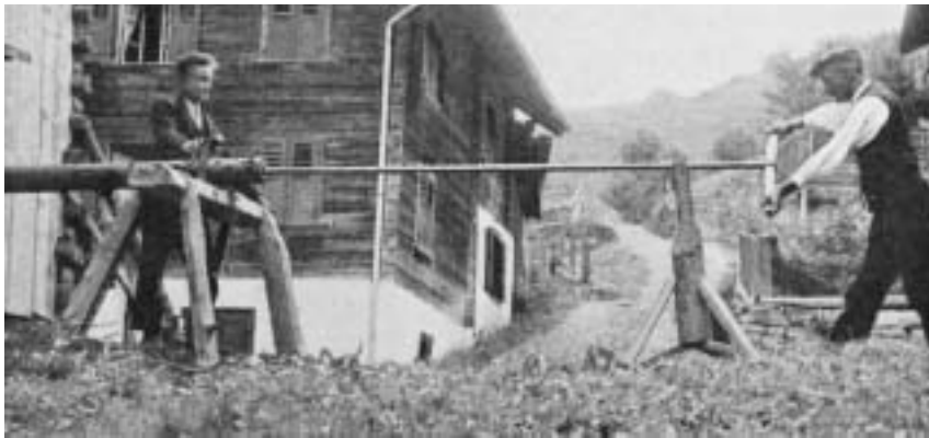
Bohren einer Röhre in Peiden: Links Holzbock mit aufliegendem Stamm, befestigt mit Kette und Reitel; rechts Stütze, wegweisende Vorrichtung für Bohrstange. Foto aus A. Maissen, Werkzeuge und Arbeitsmethoden des Holzhandwerks, 1943.
