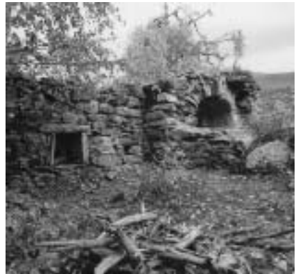
Anbau (4) mit Wandnische und Stichbogentüre zum Binnenhof
